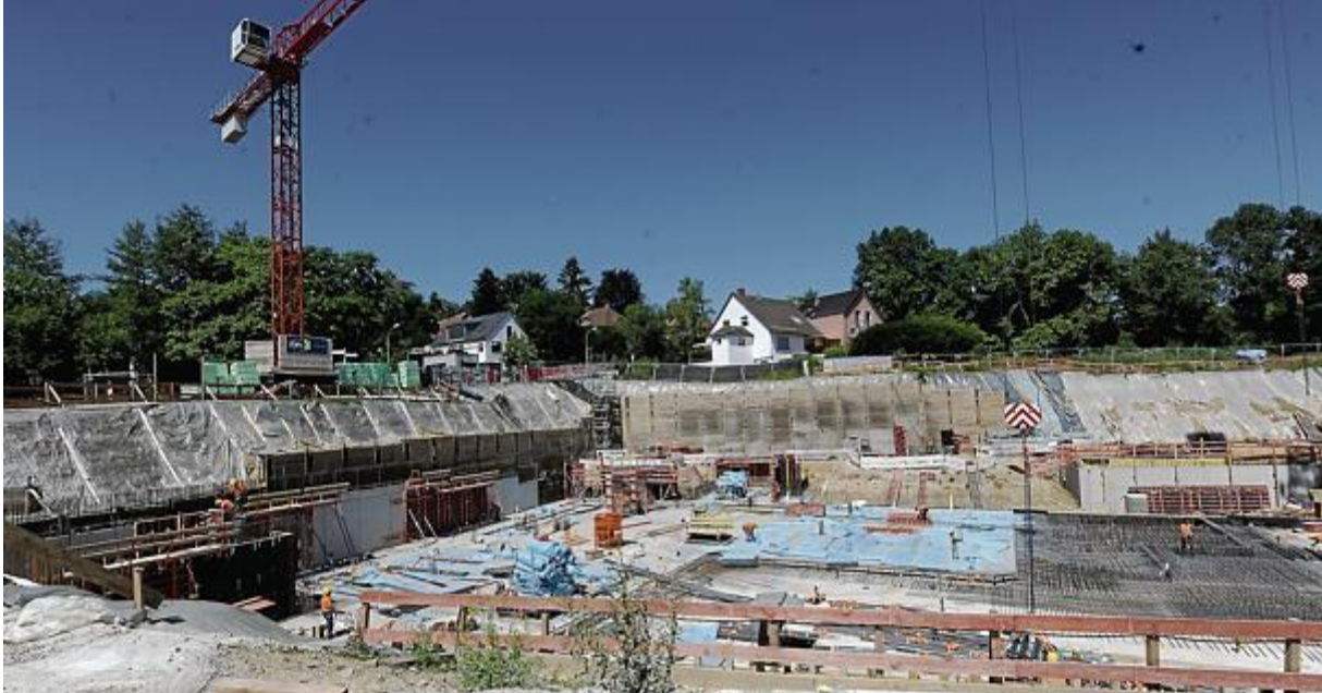
Baugrube Kronberg Bahnhof
